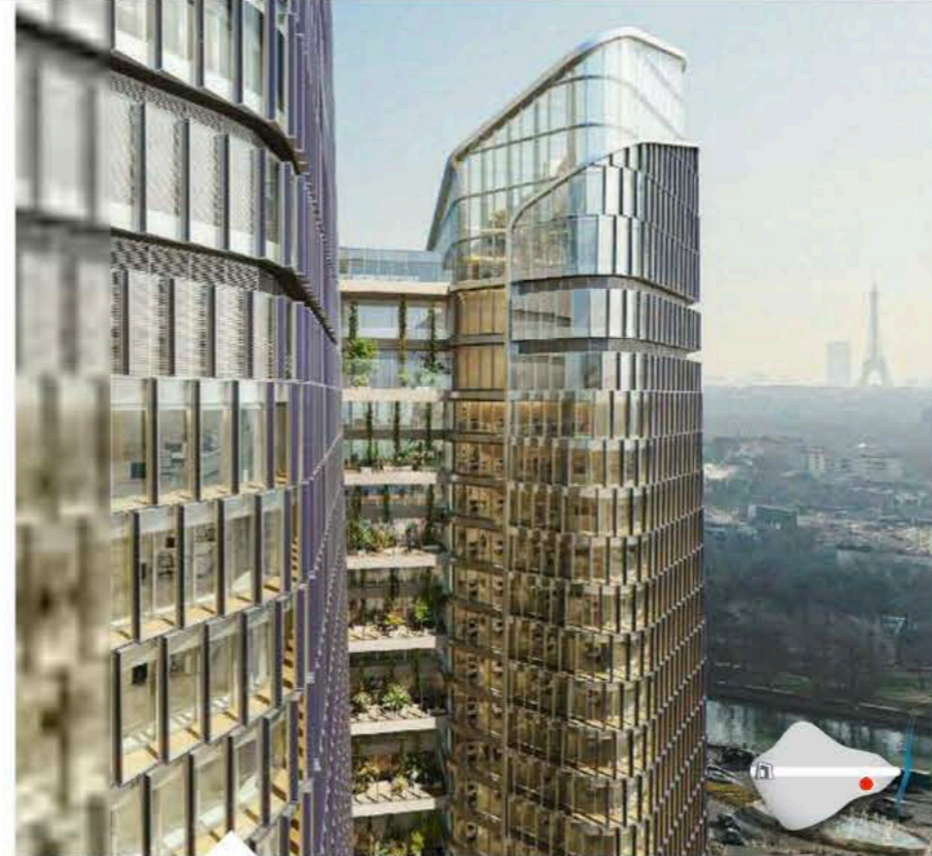
THE LINK. Portée par Groupama, conçue par l'agence PCA-Stream et construite par Vinci Immobilier, cette tour deviendra en 2025 le siège de Total. Sur 130 000 m 2 , elle se compose de deux ailes, Arche (228 mètres) et Seine (165 mètres), reliées entre elles sur 30 étages.
