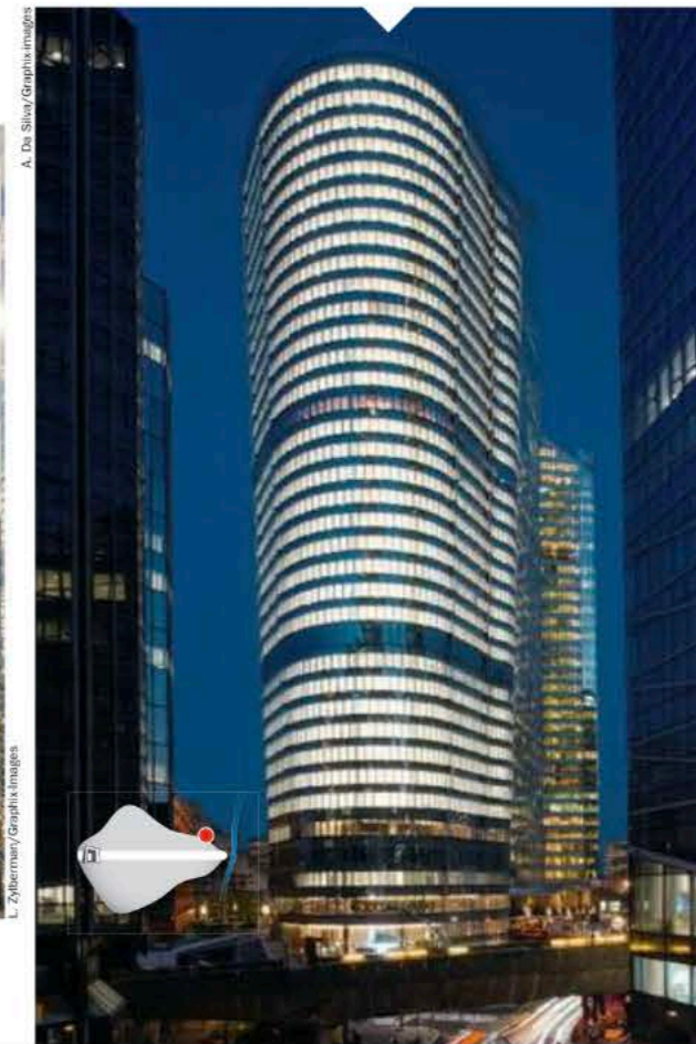
ALTO. Signée par IF Architectes pour LaSalle IM, cette tour surprend : si elle se déploie sur 51 000 m 2 et culmine à 152 mètres, la surface des niveaux augmente avec les étages : 700 m 2 au pied de la tour, mais 1 700 m 2 au sommet.
