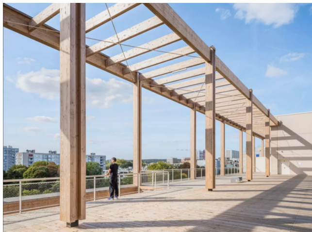
Le belvédère du nouveau Centre Pompidou dominant la ville de Massy, avec son plancher de bois de sapin et son écran de béton sable. sergio GRAZIA
