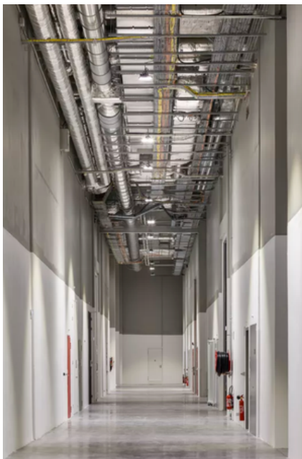
Les couloirs de ce grand bunker avec ses immenses couloirs aux structures apparentes donnant accès aux réserves. sergio GRAZIA
